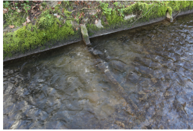
Sohlen- und Uferverbauung
