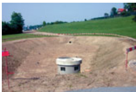
Abbildung 26: Retentionsfilter- becken Talacher. Strassenabwas- serbehandlungs- anlage in Bau (links und im Be- trieb (rechts))
