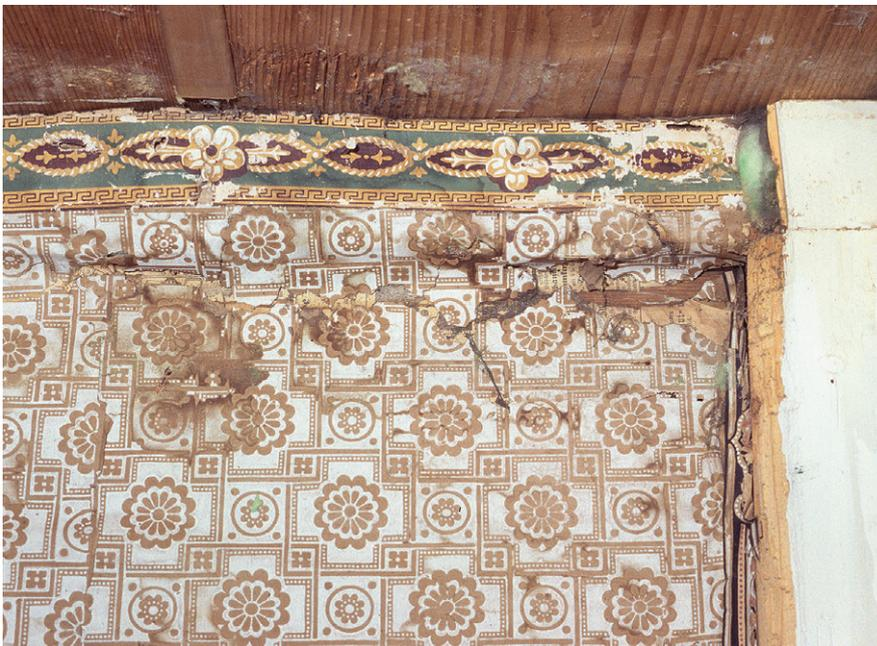
Abb. 145: Ungeborgene grün-goldene Bordüre und weisse Tapete mit Kreuzen und Blumen, Fnr. 1665.32.3, in situ an ihrer Fundstelle. Unterägeri, Chammersbüel, erstes Dachgeschoss, Raum 3.2, obere südliche Ecke der Ostwand. Tapete: 1903 oder danach, ungrundiertes Endlospapier, vermutlich maschineller Zylinderdruck, eine Farbe. (Bordüre mit dem vermutlich gleichen Muster: Fnr. 1437.187.9
