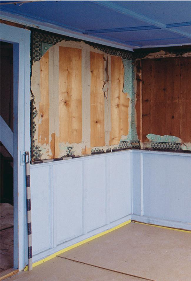
Abb. 476: Zug, Kirchmattstrasse 10, ehemaliges Pfrundhaus, erstes Dachgeschoss, Raum 3.1, Ostwand. Bevor man die Tapetendekoration in der Dachkammer anbrachte, überklebte man die Fugen zwischen den Holzbrettern mit Papier.
