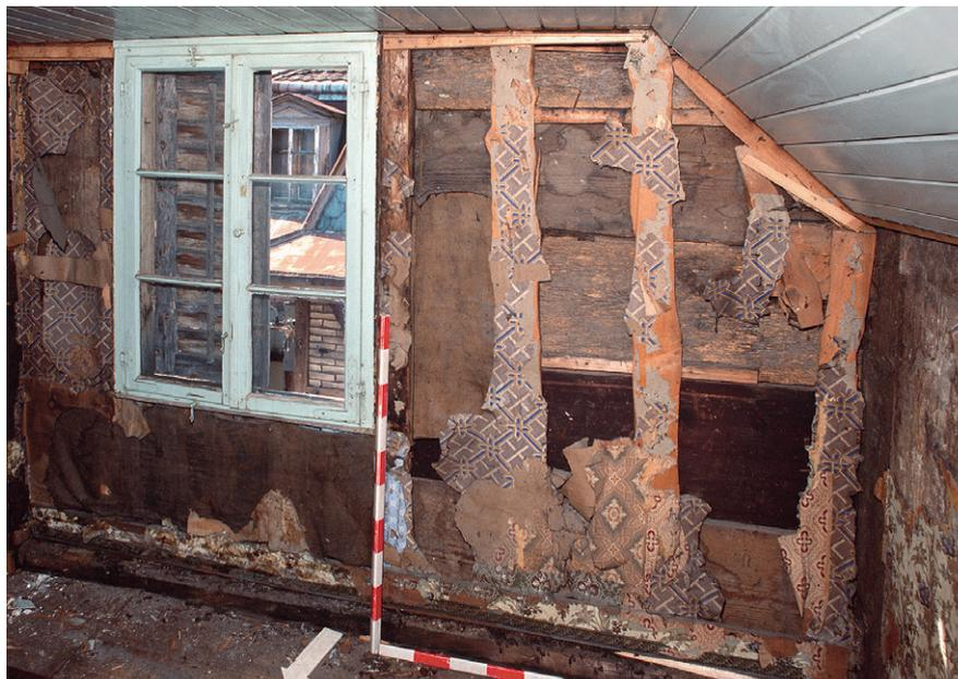
Abb. 259: Baar, Rathausstrasse 6/8, zweites Dachgeschoss, Raum 5.2, Südwand. Für die Anbringung einer Tapetendekoration wurde ein Holzgitter erstellt, dieses wurde mit einer Papiermakulatur beklebt, über welcher man verschiedene Tapetenschichten anbrachte.
