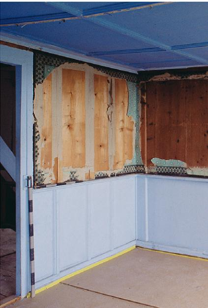
Abb. 256: Zug, Kirchmattstrasse 10, ehemaliges Pfrundhaus, erstes Dachgeschoss, Raum 3.1, Ostwand. Bevor man die Tapetendekoration in der Dachkammer anbrachte, überklebte man die Fugen zwischen den Holzbrettern mit Papier.
