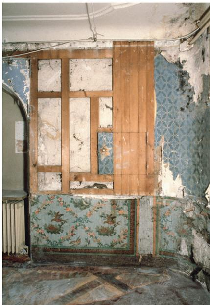
Abb. 258: Zug, Ägerstrasse 9, zweites Vollgeschoss, Raum 2.13, Südwestecke. Für die vermutlich erste Tapezierung im Raum erstellte man ein Gitter aus Holzlatten. Darüber wurde ein Jutestoff gespannt, den man mit einer Papiermakulatur beklebte, bevor die Tapezierung erfolgte. Die erste Tapetendekoration ist im untersten Wandbereich zu erkennen, sie bestand aus mehreren unterschiedlichen Tapetentmustern, die man geschickt kombinierte.
