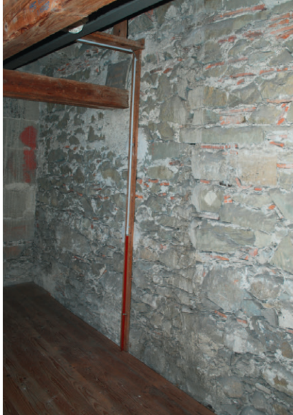
Abb. 128 (oben links): Baunaht in der Obergadenwand im Dachraum des nördlichen Seitenschiffs (S n III/s).
