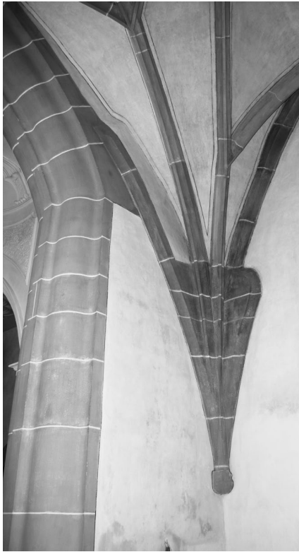
Abb. 109 (links): Gewölbeansatz an der westlichen Zungen- mauer im Nordseiten- schiff (S n V/sw).
