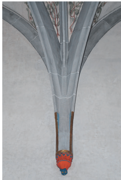
Abb. 77 (links): Gewölbeanfänger und Dienstkonsole an der südlichen Chorwand (C4/s).
