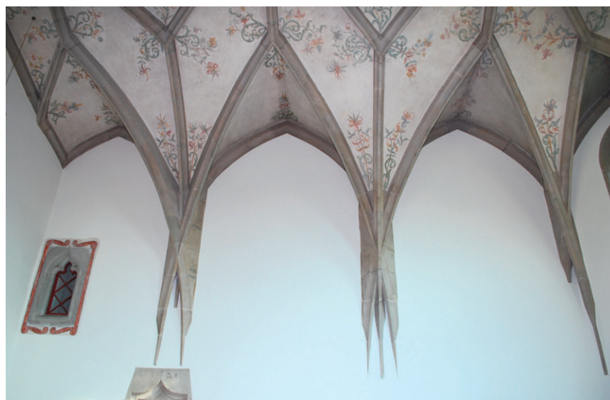
Abb. 355: Mettmenstetten ZH, Pfarrkirche. Gewölbeansatz an der Nordwand des Chors.
