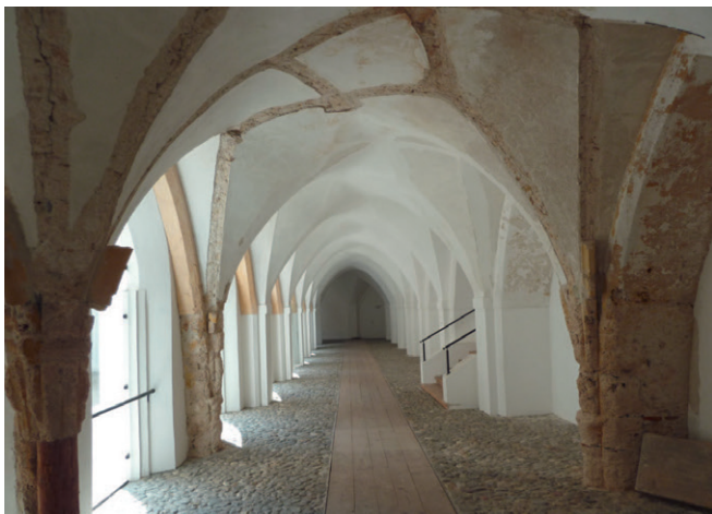
Abb. 54, 55: Mondsee (Oberösterreich), Kreuzgang des ehemaligen Stifts. Das Abschlagen der spätgotischen Rippen im Barock hatte offensichtlich keinen Einfluss auf die Statik des Gewölbes.
