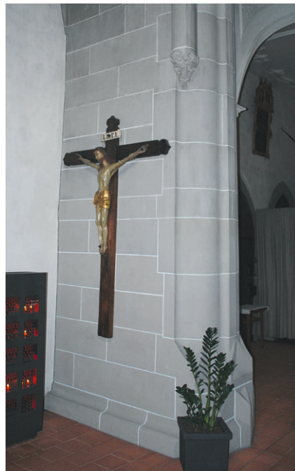
Abb. 97 (links): Zungenmauer an der Westseite mit Kehlung des ehemaligen Aussensockels.
