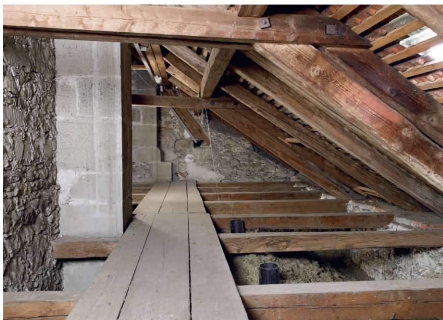
Abb. 128 (oben links): Baunaht in der Obergadenwand im Dachraum des nördlichen Seitenschiffs (S n III/s).
