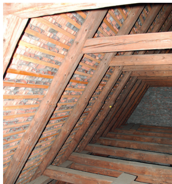
Abb. 127: Dachstuhl des Mittelschiffs, Sparrenlage zwischen Kehlbalken- und Hahnenbalken.
