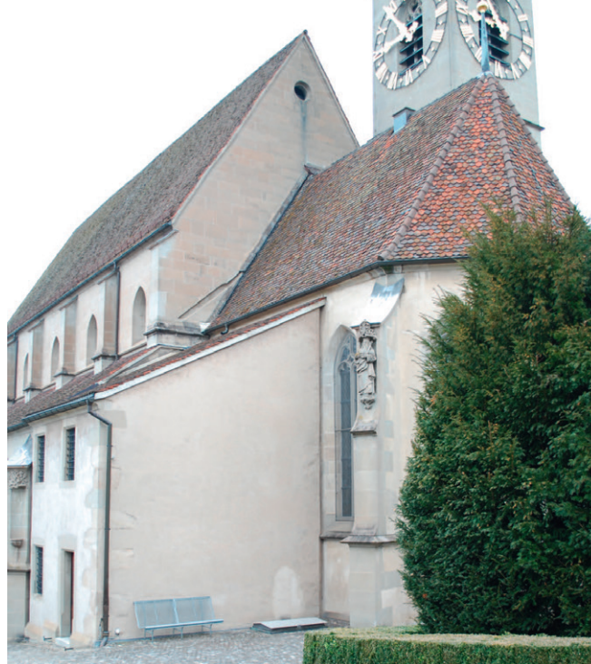
Abb. 84: Zug, Kirche St. Oswald. Ansicht der Sakristei von Südosten mit der Nut des barocken Pultdaches an der Mittelschiffgiebelwand.
