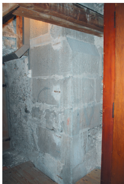
Abb. 58 (links): Obergadenwand im Dachraum über dem nördlichen Seitenschiff ( S_{n,dlII/s} ). Die Aufmauerung erfolgte 1544/1545 mittels einer Schalung.
