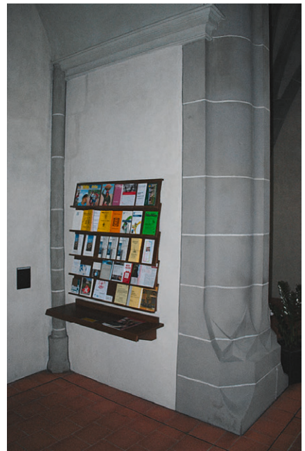
Abb. 91: Innenseite der nördlichen Zungenmauer an der Westmauer (M6/n) mit dem Dienst für das Gewölbe des verlängerten Langhauses.
