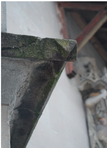
Abb. 64 (oben): Detail der sich gegenseitig durchstossenden Gesimskanten an der Westfassade.
