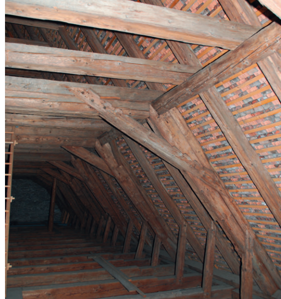
Abb. 125: Dachstuhl des Mittelschiffs, Binder- gespärre XIII/IX mit Windstreben auf der Südseite.
