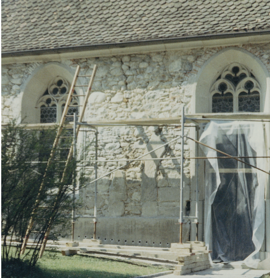
Abb. 35: Zug, Friedhofskapelle Mariahilf. Freigelegte Nordwand mit den Resten der vermauerten Spitzbogenöffnungen 1968.
