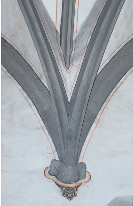
Abb. 346: Pfäffikon ZH, Pfarrkirche. Gewölbeansatz mit Datierung 1488.
