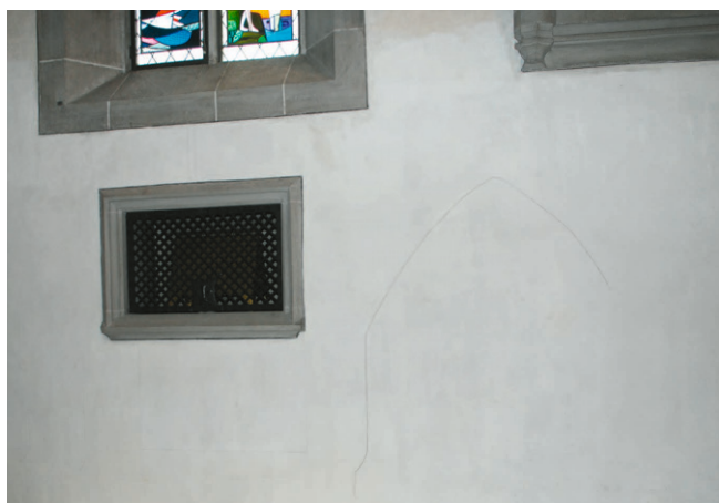
Abb. 115: Südwand im ersten Joch des südlichen Seitenschiffs (S s I/s) mit eingeritztem Verlauf der Spitzbögen der ehemaligen Tribüne.
