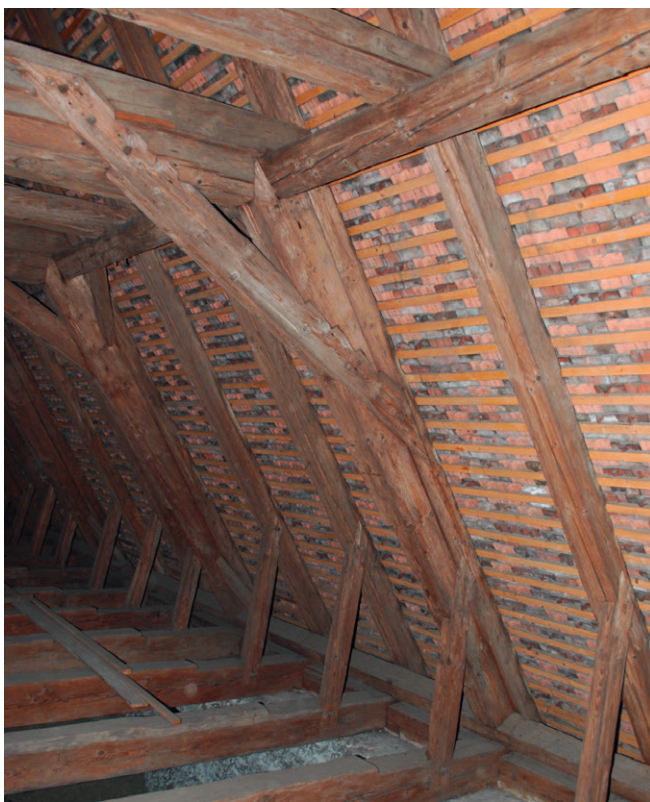
Abb. 127: Dachstuhl des Mittelschiffs, Sparrenlage zwischen Kehlbalken- und Hahnenbalken.
