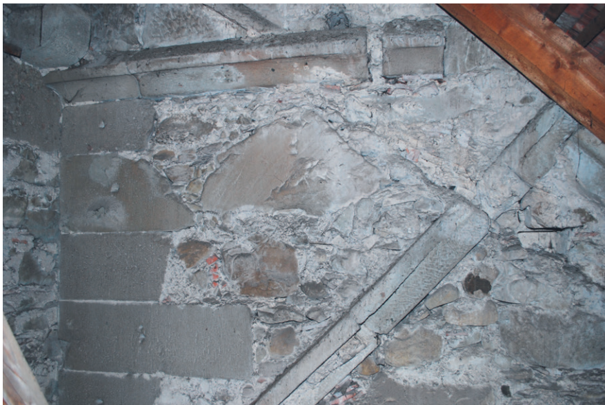
Abb. 60 (oben): Südseite des Turms im Chordachraum (CdV/n, T3/s) mit schräg verlaufendem Gesims und Nut früherer Chordachanschlüsse.
