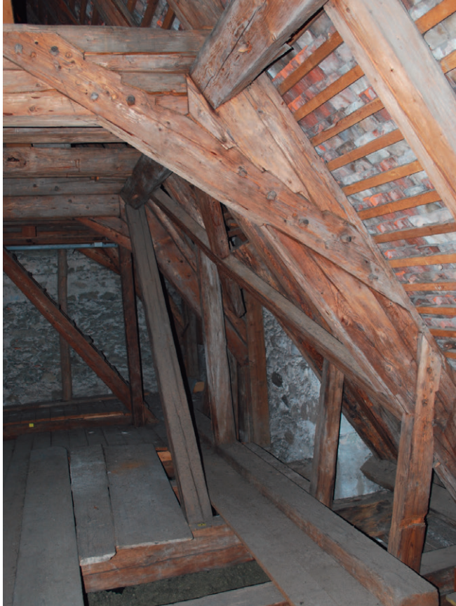
Abb. 125: Dachstuhl des Mittelschiffs, Binder- gespärre XIII/IX mit Windstreben auf der Südseite.
