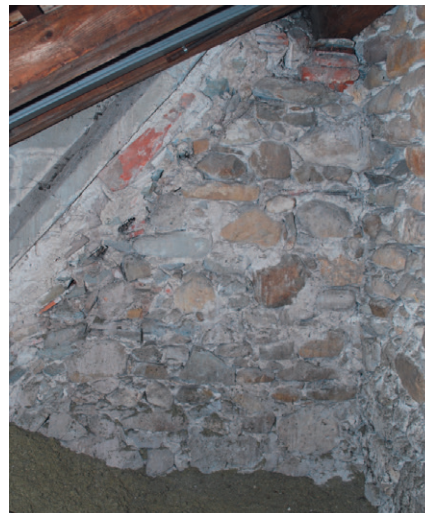
Abb. 86 (links): Ostwand (Chorbogenwand) im Dachraum des südlichen Seitenschiffs mit eingemauertem Traufgesims der ersten Sakristei von 1481–1483.
