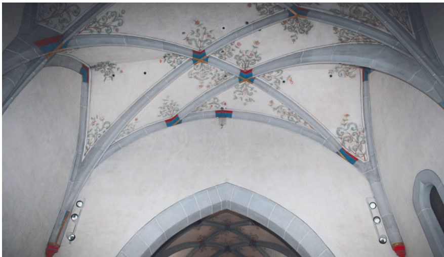
Abb. 81: Gewölbeansatz am Chorbogen.
