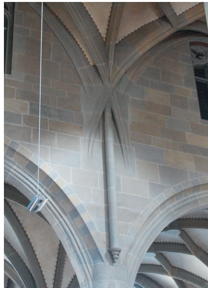
Abb. 351: Überlingen (Baden-Württemberg), Münster St. Nikolaus. Gewölbeanfänger im inneren Seitenschiff.
