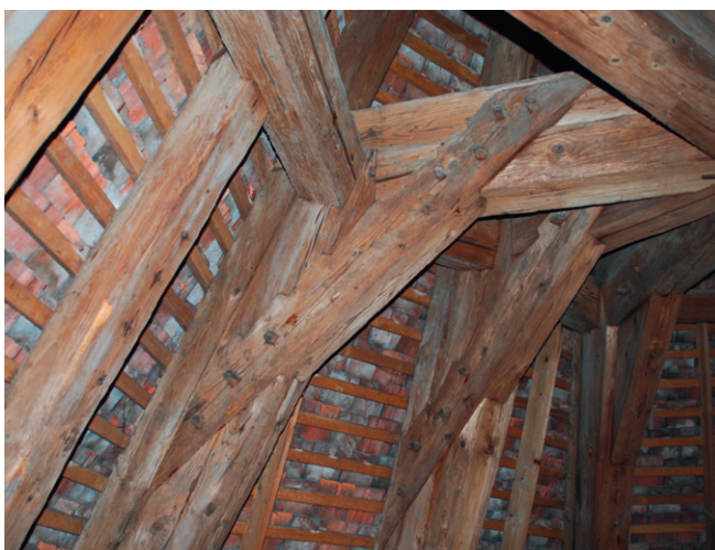
Abb. 123: Chordachstuhl. Kopfbänder des östlichen Abschlusses.
