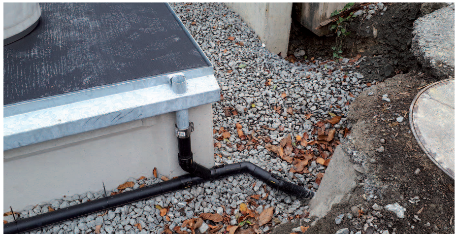
Betonelement eingebaut in sickerfähigem Schotter und Ableitung des Oberflächenwassers in ein Vorflutsystem.
