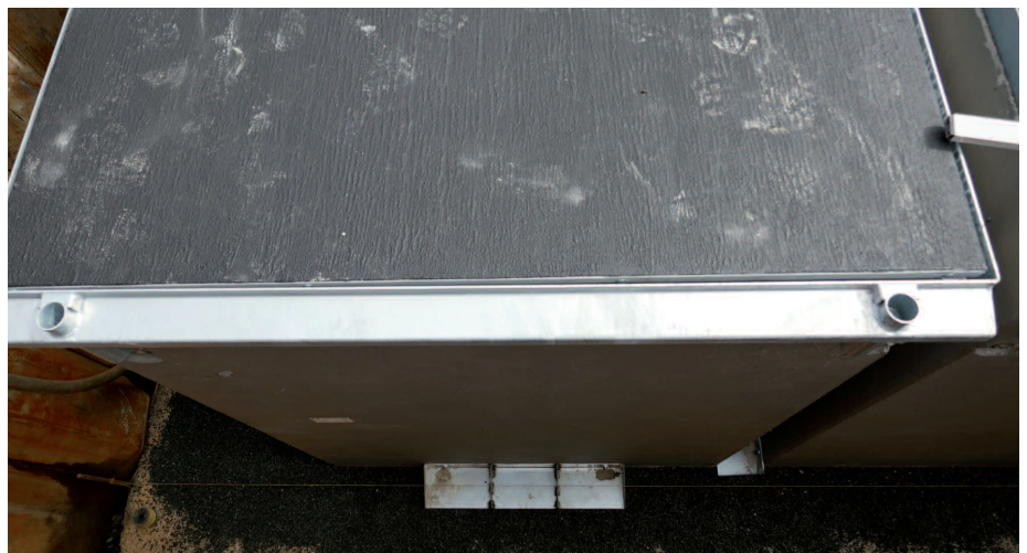
Mit Betonhaltern versehenes Betonelement gegen Auftrieb im Grundwasser
