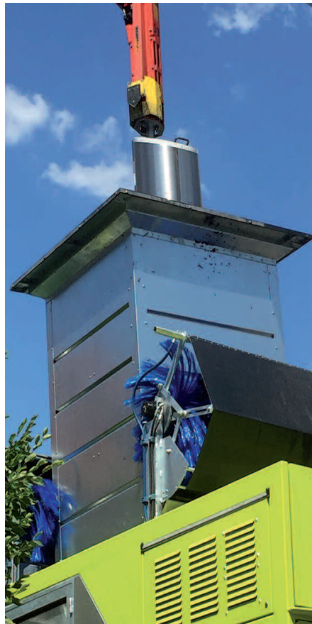
Reinigung des Containers mit Walzenbürsten
