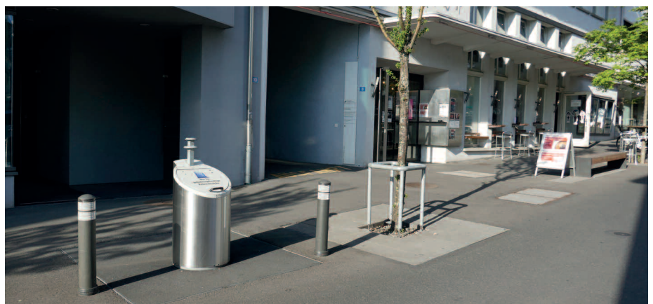
Beispiel einer UFC-Anlage mit engen Platzverhältnissen an der Schmidgasse in der Stadt Zug
