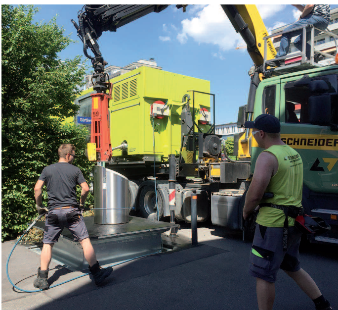
Reinigung der Gehwegplattform und Einwurfsäule mit Wasserhochdruckreiniger
