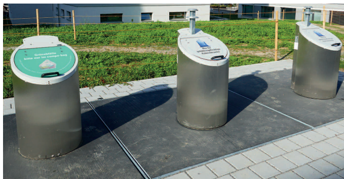
Unterfluranlage mit zwei UFC für Hauskehricht und einem Liftomaten für Grünabfälle
