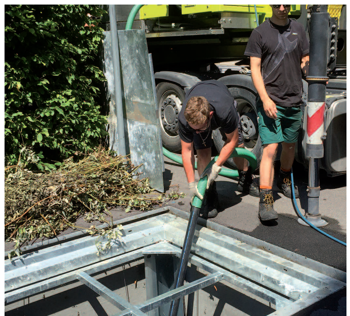
Reinigung des Betonelementes mit Wasserhochdruckreiniger
