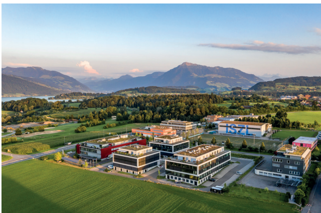
Arbeitsgebiet Bösch, Sicht Richtung Süden
