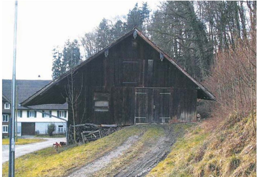
Ostfassade Remise vor der Demontage des Schleppdaches (Bild 2004)
