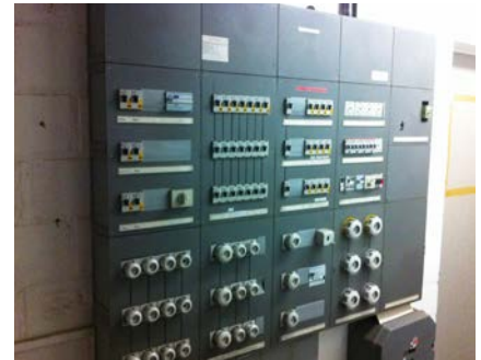
Ungesicherter Elektroschrank
