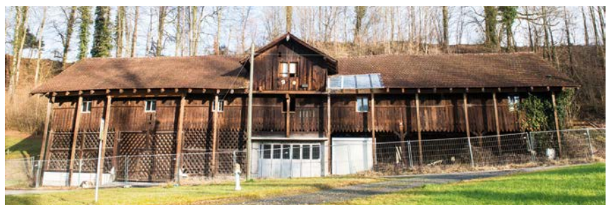
Südfassade Remise Ist-Zustand (mit vorgesetztem Stützenkorsett, Schleppdach entfernt)
